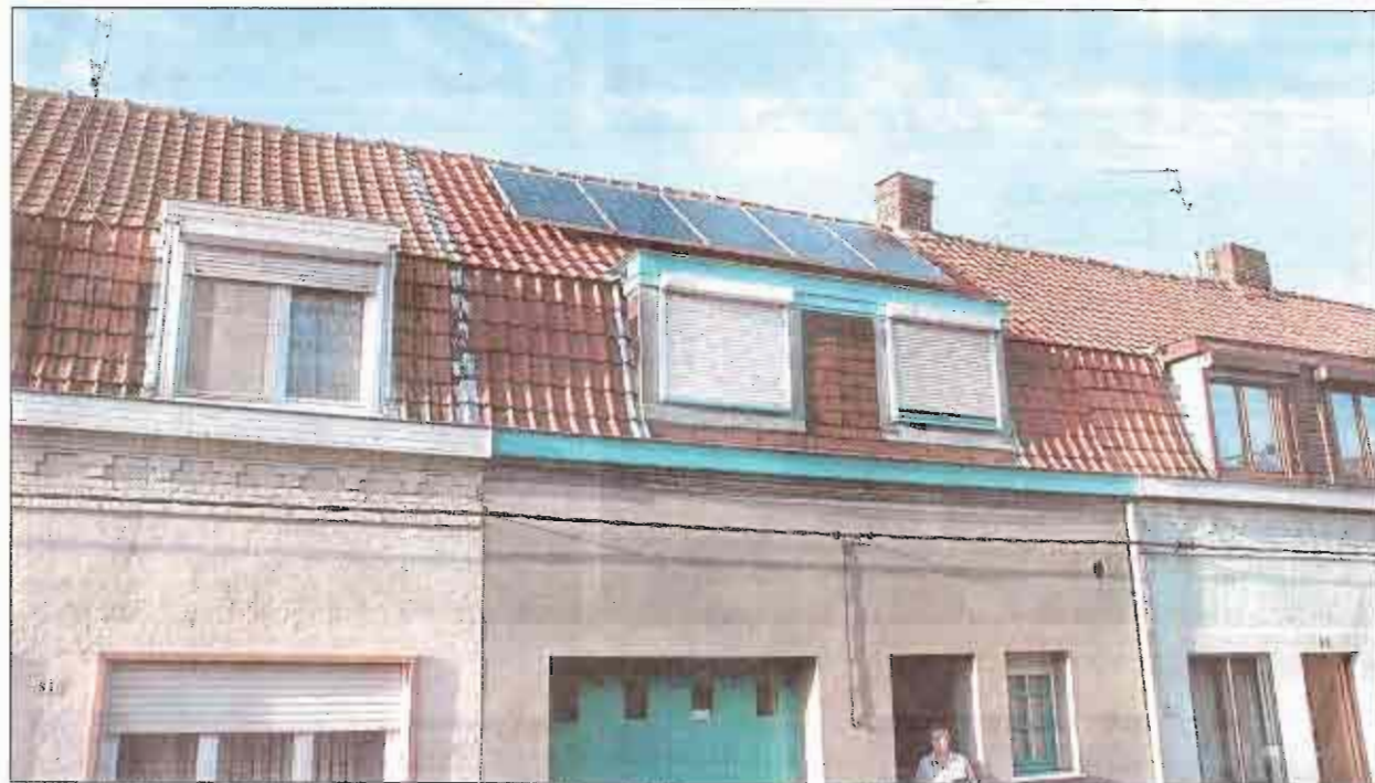
Cette installation de 1,25 kWc permettra à son propriétaire de diminuer sa facture d'électricité d'environ 30 %.
